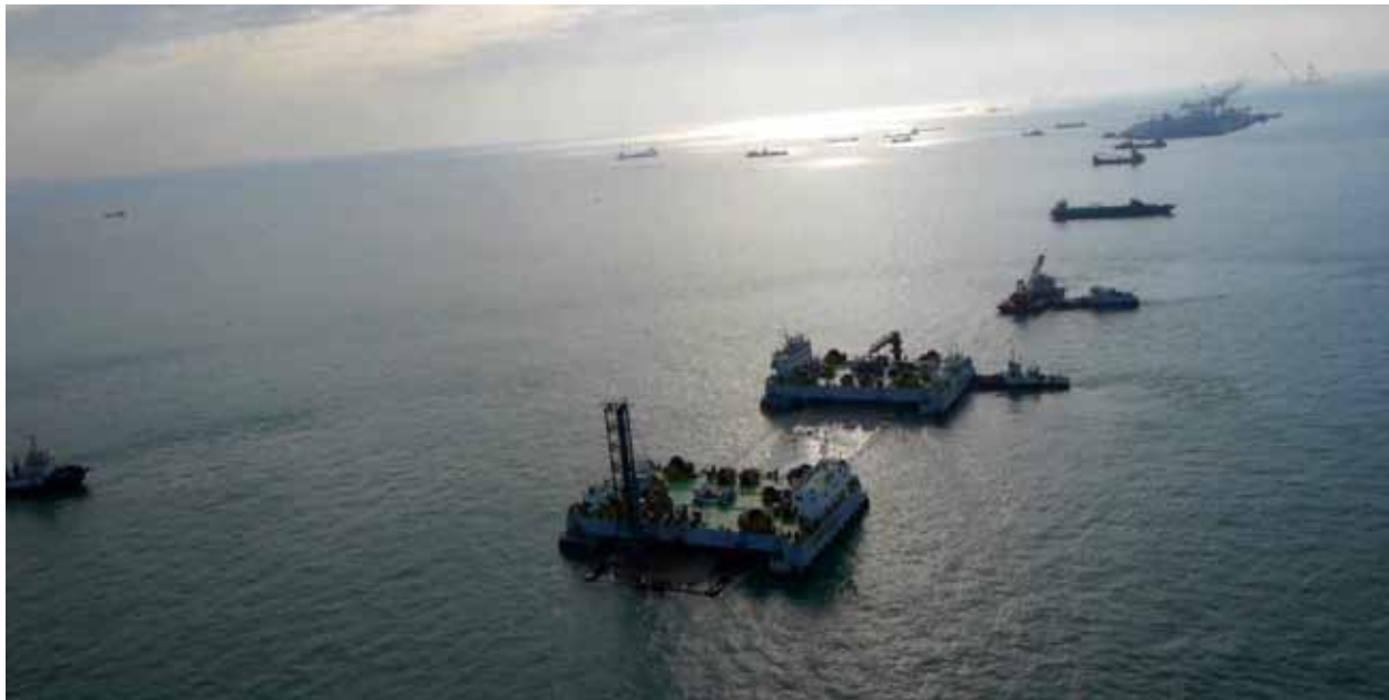
◎ 港珠澳大桥检查现场。摄 / 宋腾飞、陆彬
