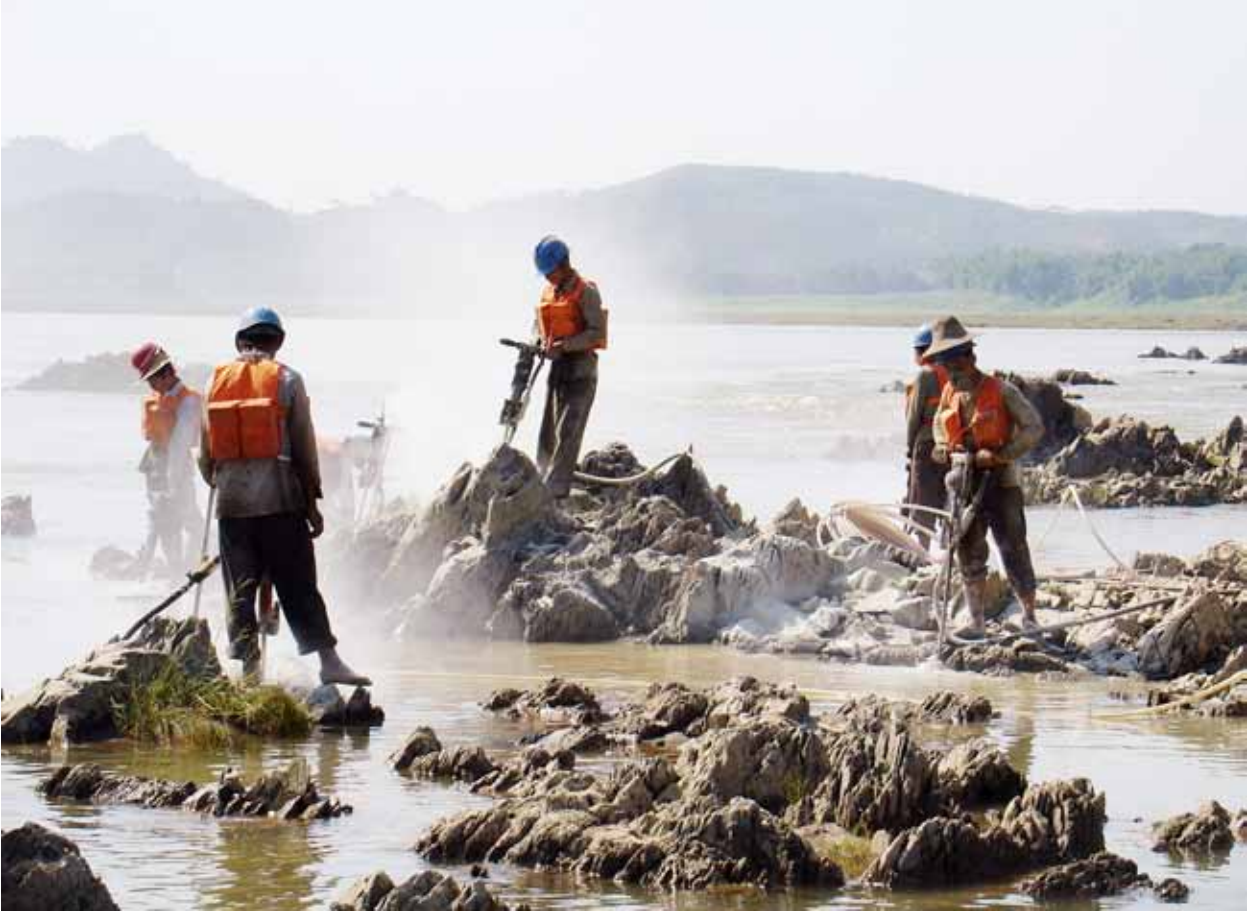
贵梧Ⅱ级航道整治现场。
